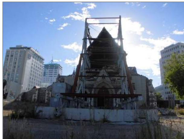
図4、修復工事中の大聖堂
