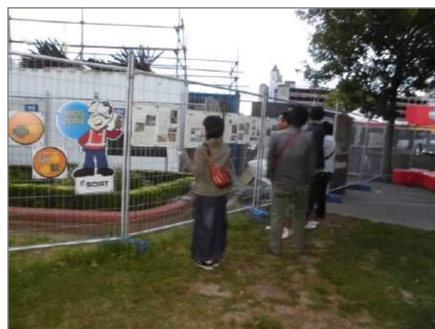
図6、修復工事の様子を見学する一行
