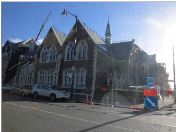
図3、修復工事中のアートセンター
